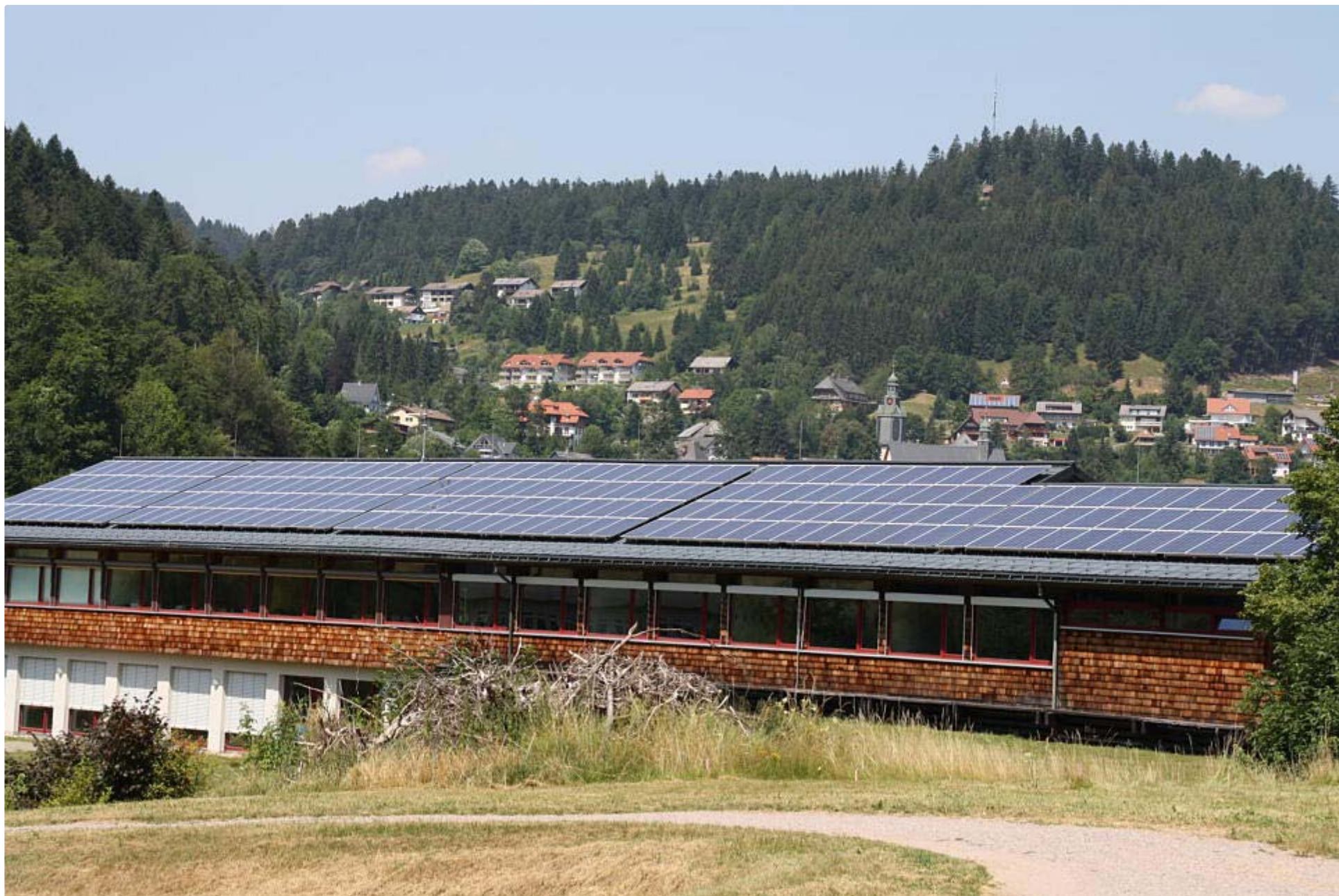
Der Schulpavillon heute: Der ursprüngliche Pfahlbau wurde 1984 großzügig erweitert. Erst später wurde auf dem Dach eine Photovoltaik-Anlage installiert. | Bild: Andreas Böhm
